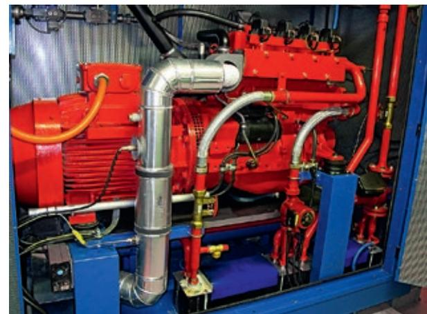
Mit dem gewonnenen Biogas wird dieses Blockheizkraftwerk betrieben. Es erzeugt einen Drittel des Strombedarfs sowie Wärme für den biologischen Prozess.
