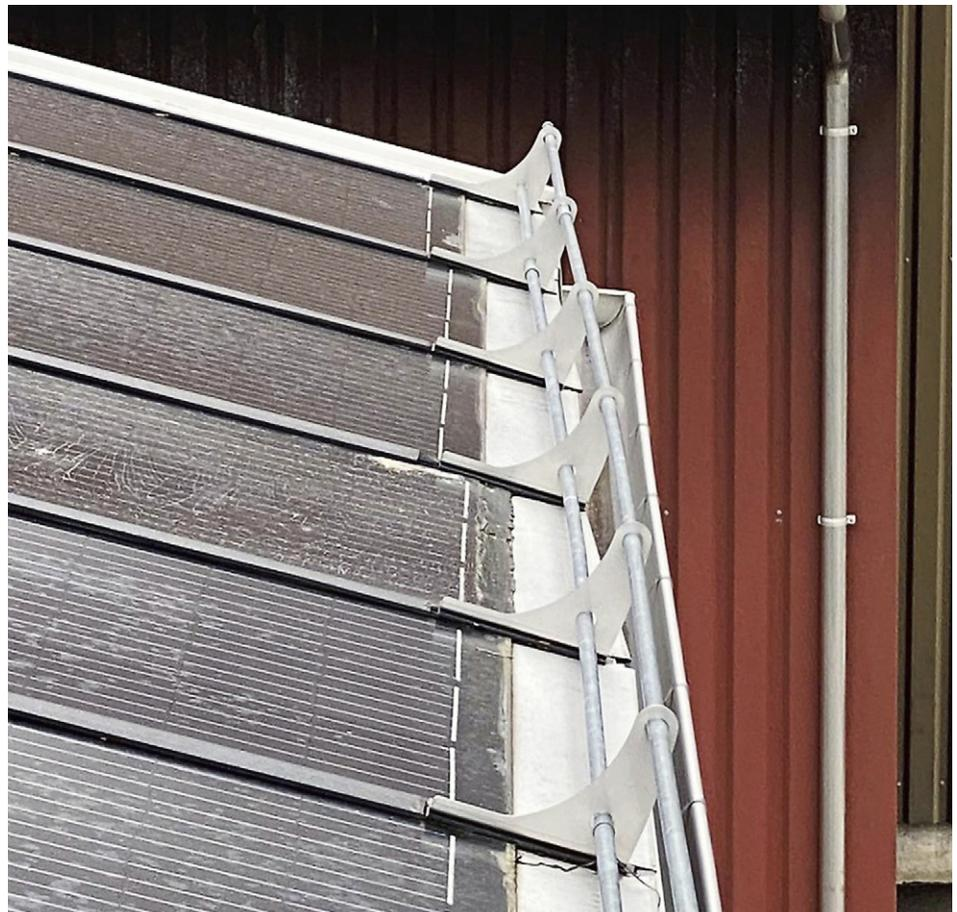
Im Bild sichtbar: Der Verzug der Unterkonstruktion unter den Photovoltaikmodulen. Foto: zVg
