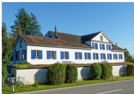
Heute ist der Hochkamin verschwunden, das Gebäude aber erhalten und zu einem Wohnhaus umfunktioniert. Foto: Marina Koller
