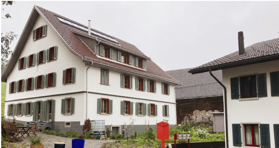
250 Jahre alt: Bauernhaus, Flarzhau und Scheune bilden eine Einheit. Das nun renovierte Bauernhaus zeigt die Möglichkeit nachhaltigen Bauens auf. Fotos: Irene Lang
