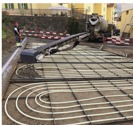
Pionierleistung: Asphaltkollektoren zur Regeneration der Erdsonden.
