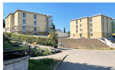
Gerbiweg 5 und 7: 2 Mehrfamilienhäuser wurden abgerissen, neu entstehen 30 Mietwohnungen (9 Studios / 6 × 2 / 7 × 3 / 8 × 4 Zimmer).
