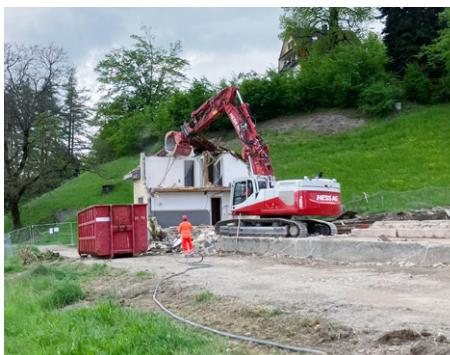
Baustelle Am Feldweg: Abriss des Bauernhofs mit Nebengebäude. Foto: Irene Lang
