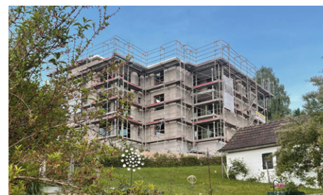
Hömelstrasse 6: Abriss des alten Hauses zugunsten von 6 Mietwohnungen (4 × 3.5 / 2 × 4.5 Zimmer).
