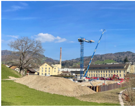
Baustelle für die Häuserzeile Jonadampfer: Links im Bild steht noch der inzwischen abgerissene Bauernhof, wo das Projekt Am Feldweg entsteht. Fotos: Esther Weisskopf
